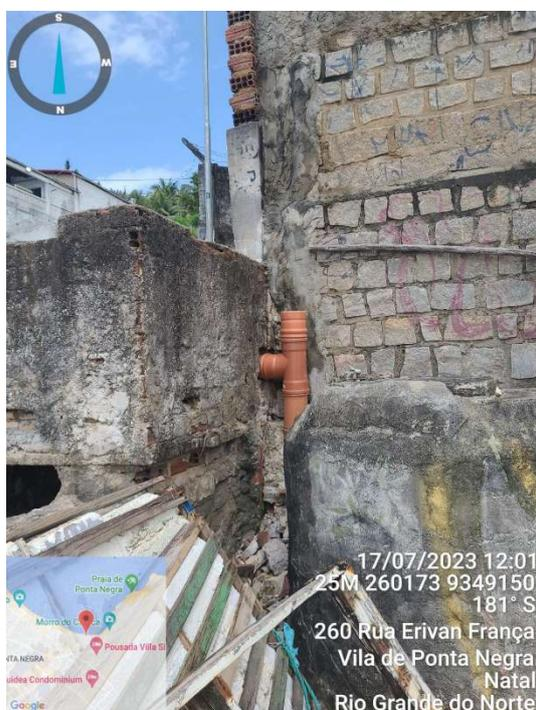
**Figura 15:** Tubulação de saída da caixa de “inspeção” – segue para a rede de coleta da Rua Erivan França.
