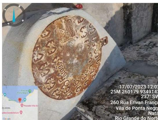
**Figura 14:** Caixa de “inspeção” feita para conter os transbordamentos.
