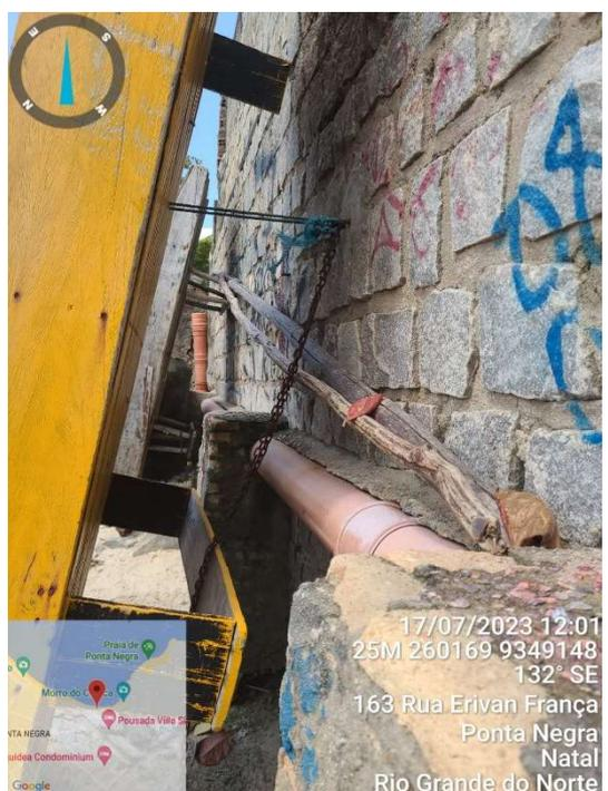
**Figura 16:** Trecho de tubulação de esgoto em frente ao muro de estabelecimento – com ancoragem.
