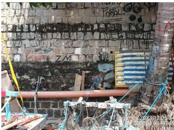
**Figura 17:** Trecho de tubulação de esgoto em frente ao muro de estabelecimento – sem ancoragem.
