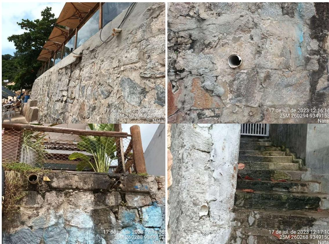
**Figura 12:** Tubulações de saída de águas pluviais de estabelecimentos para a praia.
